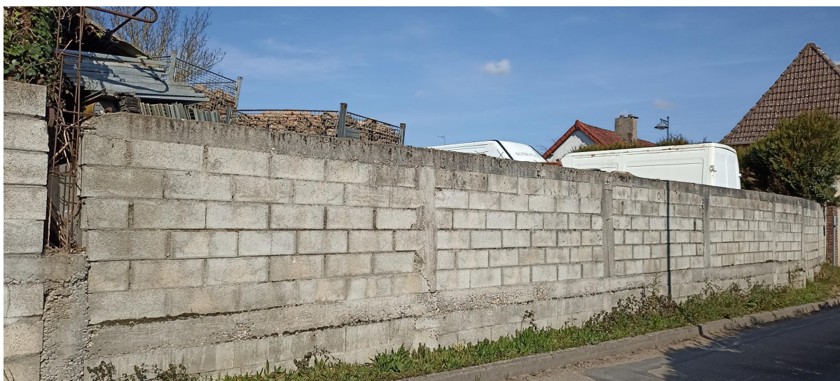
Terrain vue rue Lucas
